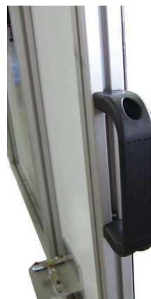
Obr. 18: Výškově přestavitelný úchyt
